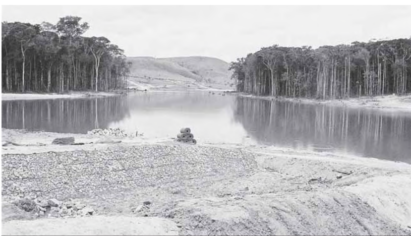
Vista parcial da Barragem Longa Vida, área fruto da cessão dos Nambikwara frente ao Termo de Compromisso assinado entre a Funai e a Santa Elina Desenvolvimento Mineral S/A
