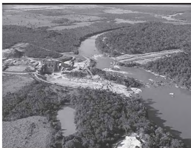
A PCH Paranatinga II em construção no Culuene já provoca danos ambientais, como o assoreamento e mudanças na vazão do rio.
