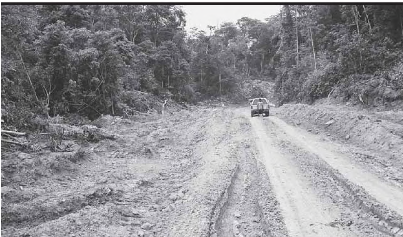
Trecho em recuperação/construção da estrada municipal não pavimentada ao sul do projeto de mineração, nas proximidades da TI Sararé.
