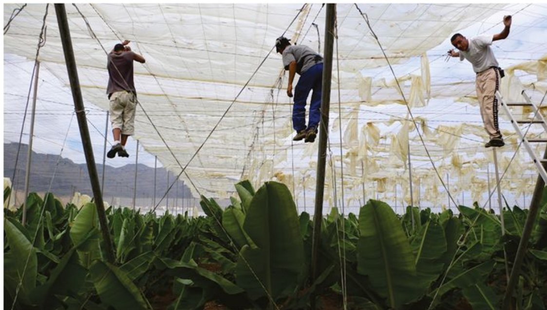
Figura 3. Reposição da cobertura de estufas nas Ilhas Canárias, Espanha.
