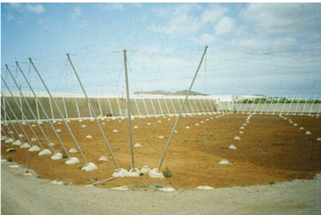
Figura 2. Construção de estufa para cultivo protegido de bananeira nas Ilhas Canárias, Espanha.
